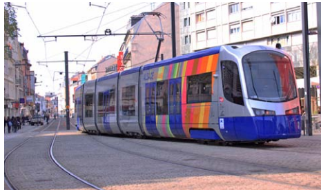
Une 3e ligne de tramway à Mulhouse
