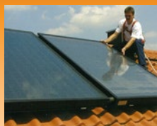
Capteurs solaires Rotex
