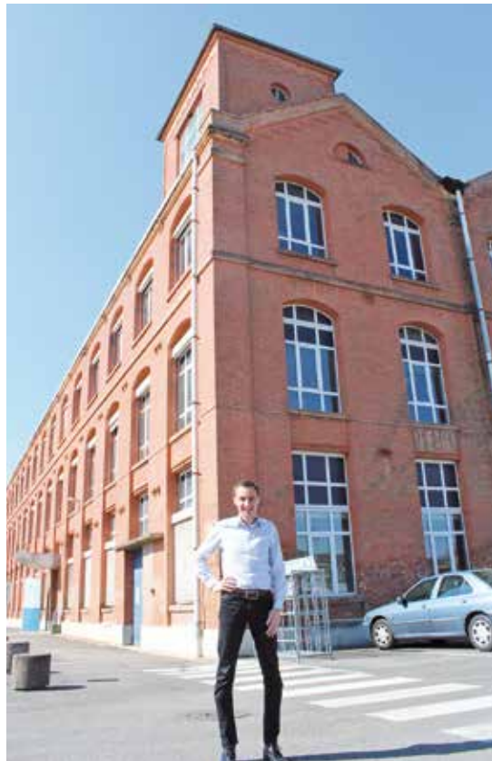
L'ancien bâtiment de la SACM pourrait bien devenir une future pépinière du numérique et de l'innovation, d'après Romain Spinali
