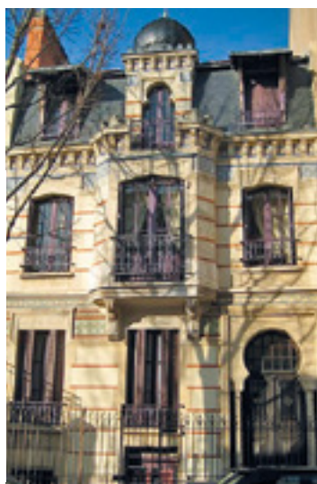
Un immeuble mauresque signé de l'architecte Henry Décoret à Vichy
