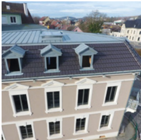
Le bâtiment a été entièrement rénové et modernisé
