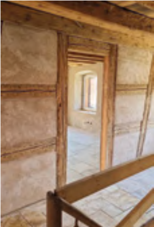
Maison Renaissance en poutres de chêne avec torchis et enduit à la chaux naturelle
